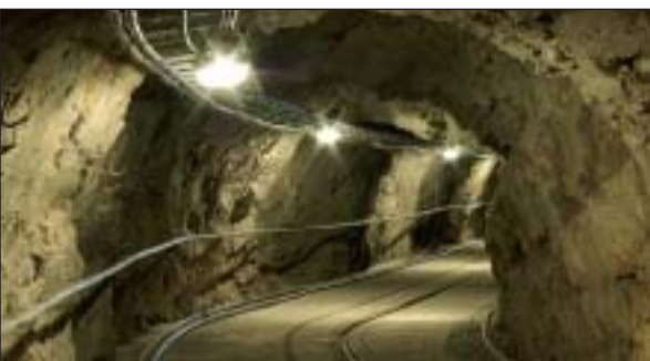
Pohled do páteřní štoly nové podzemní laboratoře
